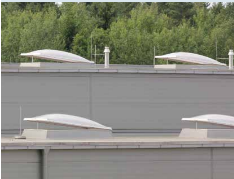
Typ L/EL Elektrische Lüftung, 230 V/50 Hz, Hubhöhen: 300 mm oder 500 mm
